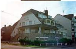
Maison dite Villa Flabeau Ninove
