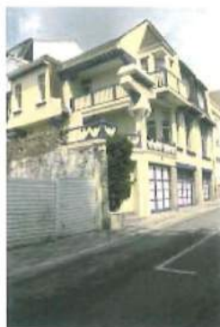
Villa «Le Quart d'heure» après travaux
