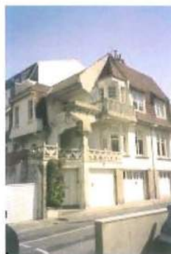
Villa «Le Quart d'heure» avant travaux
