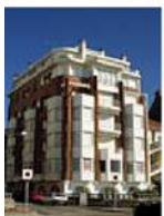
hôtel de voyageurs Scampolo, puis immeuble d'habitation
