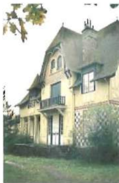
Villa dite « Nirvana » - façade *
