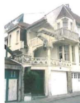
Villa «Le Quart d'heure» avant travaux et démolition de la parcelle voisine *
