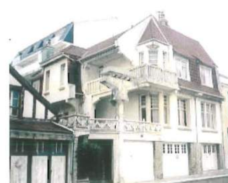
Villa «Le Quart d'heure» avant travaux et démolition de la parcelle voisine *
