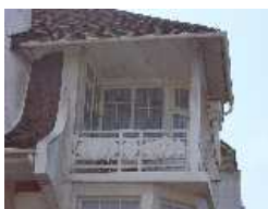
Villa " Karidja " - 1927 (Architecte : Horace Pouillet) Avenue de la Reine Victoria
