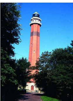
" Le Phare de la Canche " - 1947 (Architecte Louis Quételart) Allée des Mésanges
