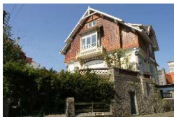
Villa " La Rafale " - 1894 (Architecte : Louis Cordonnier) 6 avenue Louis Hubert
